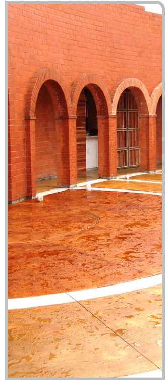
Concreto pulido con aplicación de ácido oxidante Sicone en 2 tonos.
