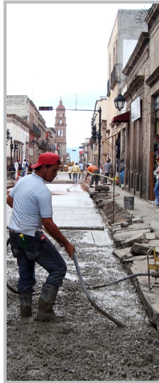
Concreto estampado color superficial color rojo, desmoldante gris.
