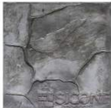
Color endurecedor: Gris Plata Desmoldante: Gris Molde: Piedra de Cañón
