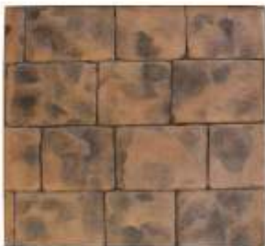
Color endurecedor: Café Desmoldante: Negro Molde: Tlaquepaque
