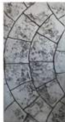
Color endurecedor: Celeste Desmoldante: Negro Molde: Abanico Grande
