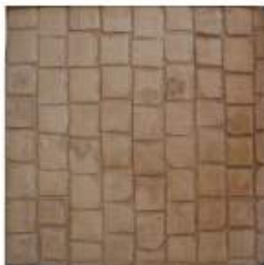
Color endurecedor: Durazno Desmoldante: Neutro Molde: Granito Irregular
