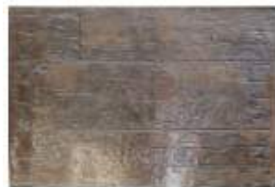
Desmoldante: Negro Molde: Tablón Madera
