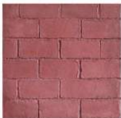
Color endurecedor: Rojo Desmoldante: Neutro Molde: Ladrillo Soga
