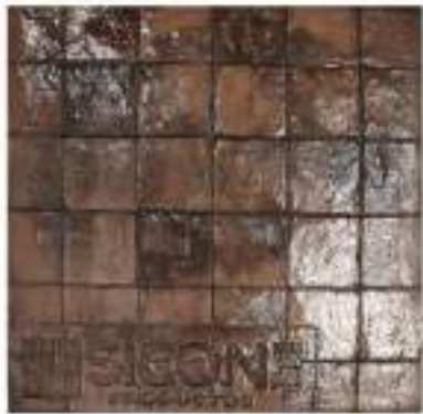
Color endurecedor: Tabaco Desmoldante: Chocolate Molde: Baldosa 10 x 10
