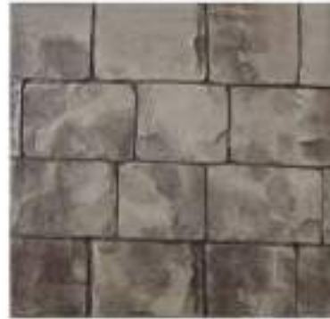
Color endurecedor: Travertino Desmoldante: Chocolate Molde: Tlaquepaque
