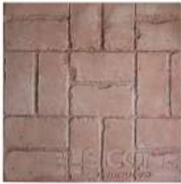
Color endurecedor: Café Claro Desmoldante: Rojo y Verde Molde: Canastilla
