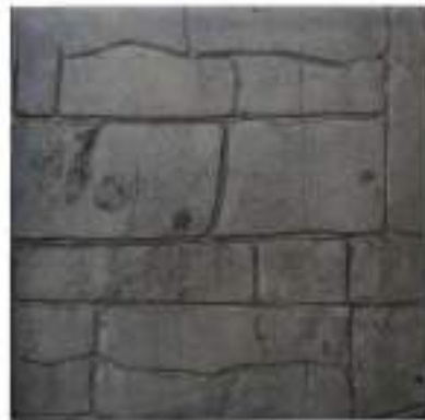
Color endurecedor: Gris Plata Desmoldante: Gris Molde: Santa lucia
