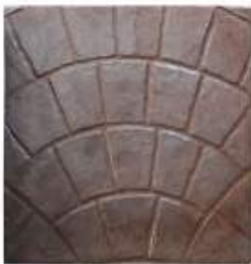
Color endurecedor: Café Claro Desmoldante: Neutro Molde: Avanico
