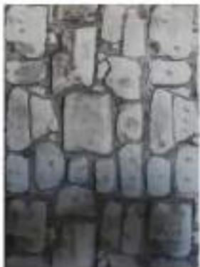
Color endurecedor: Plata Desmoldante: Gris Molde: Europiedra
