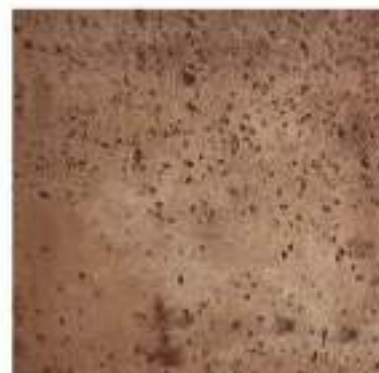
Color endurecedor: Travertino Desmoldante: Chocolate Molde: Piel Coquina
